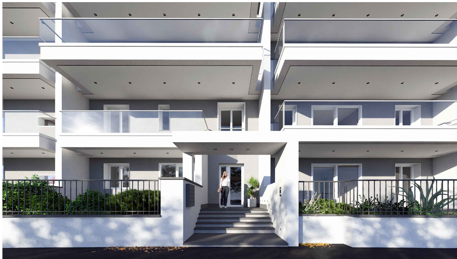
EST - Particolare dell'ingresso
